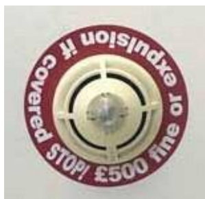
Image 2 détecteur de fumée/chaaleur dans la pièce
