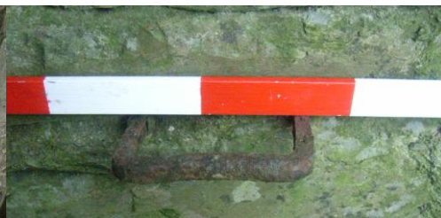
Fig. 43: Coal store (W wall, int.) (RIMG0137)
