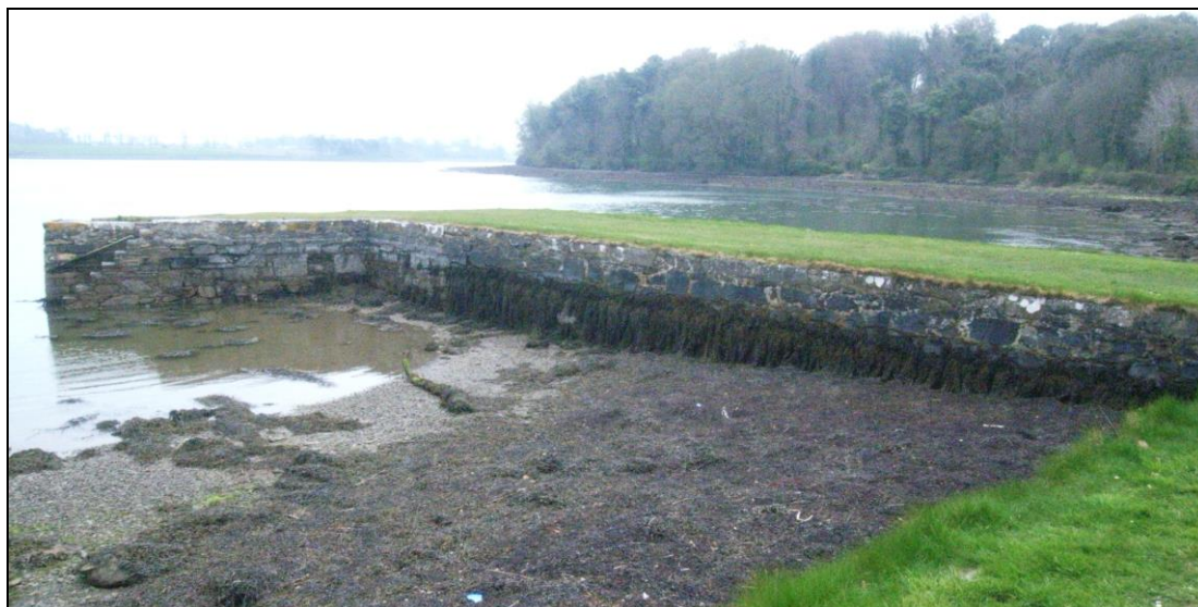
Fig. 31: Coal Quay. (RIMG0087)
